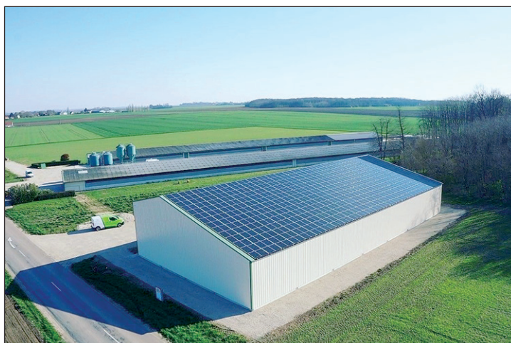
Plusieurs achats groupés de centrales photovoltaïques ont vu le jour.
