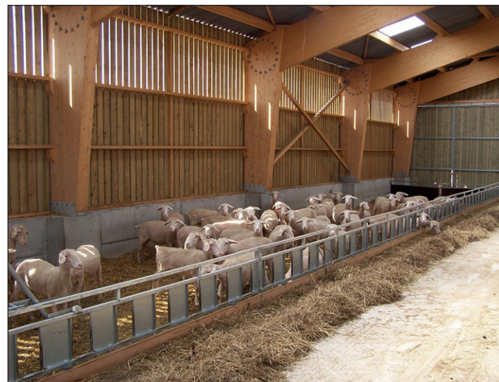
Le bois étant un matériau «chaud», il présente d'intéressantes capacités d'isolation acoustiques et thermiques.
